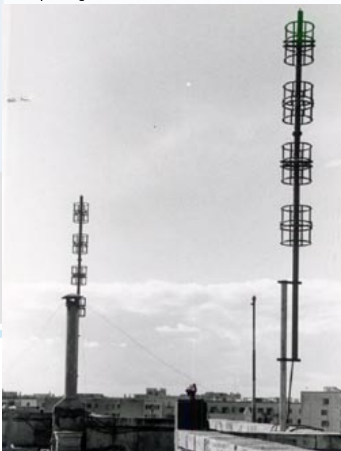
Antenne del controllo negli anni '50
