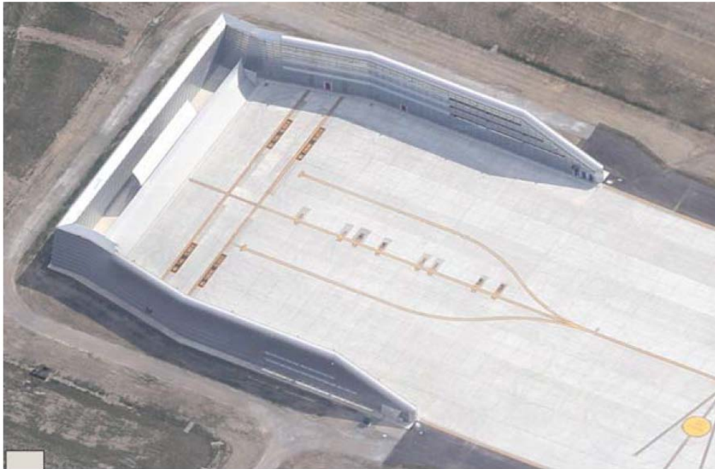
Esempio di piazzola prova motori a tre pareti
