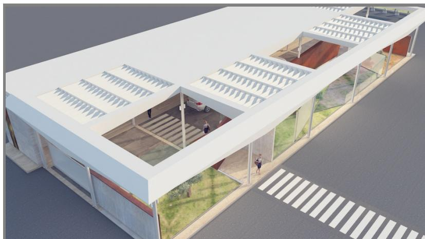
Le campate sono quindi divise in 10 rettangoli. Dei dieci rettangoli, 3 sono coperti, 3 aperti in corrispondenza delle piante a fusto, 4 sono semicoperti tramite lamelle metalliche per dare effetto semitrasparenza, lasciando cioè passare la luce, ma allo stesso tempo garantendo psicologicamente la sensazione di essere "All'interno" del Terminal.
