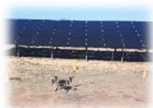
Termografie con droni e AI
