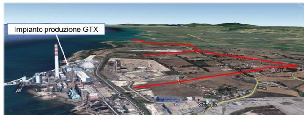
Torrevaldaliga Nord – Impianto termoelettrico
