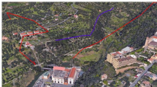
Acquoria – impianto idroelettrico
