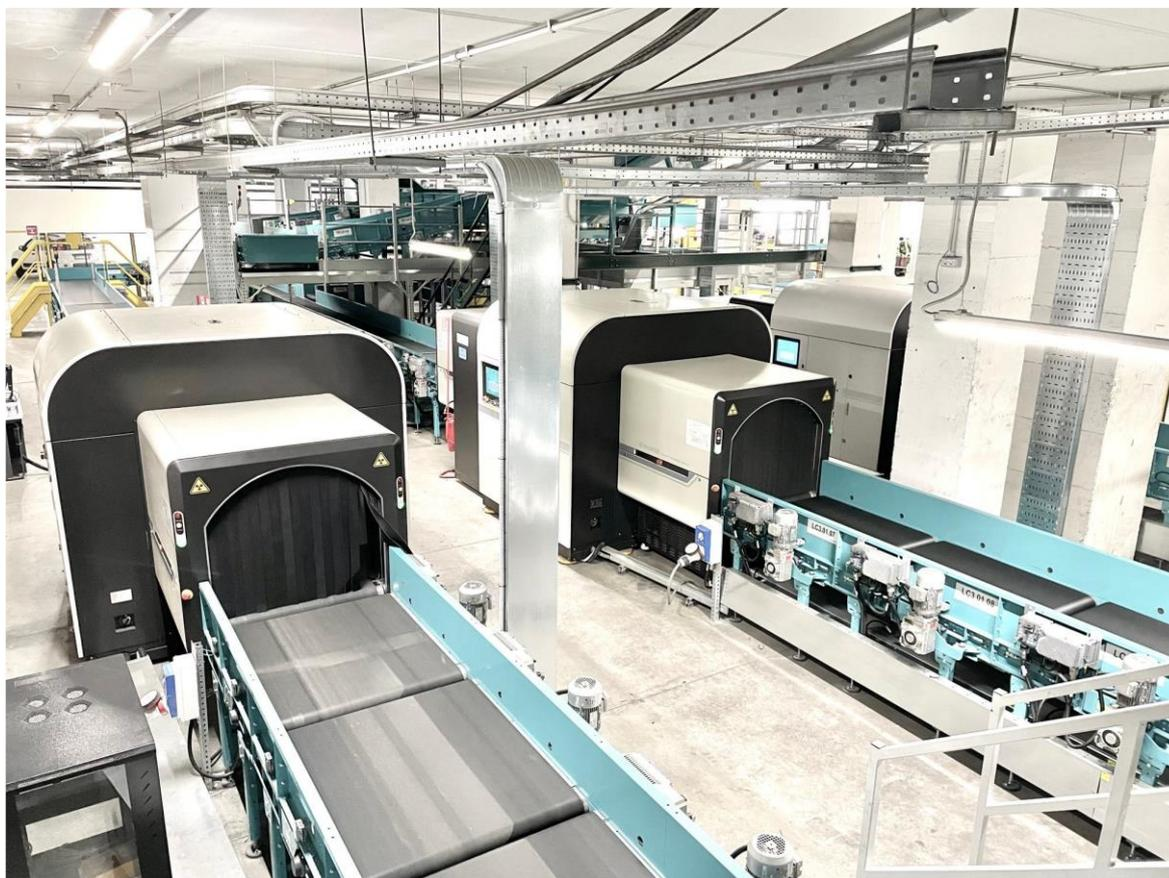
Figura 21: Adeguamento del sistema BHS allo standard 3
