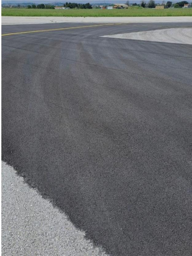
Figura 2: riqualifica localizzata pavimentazione TWY T
