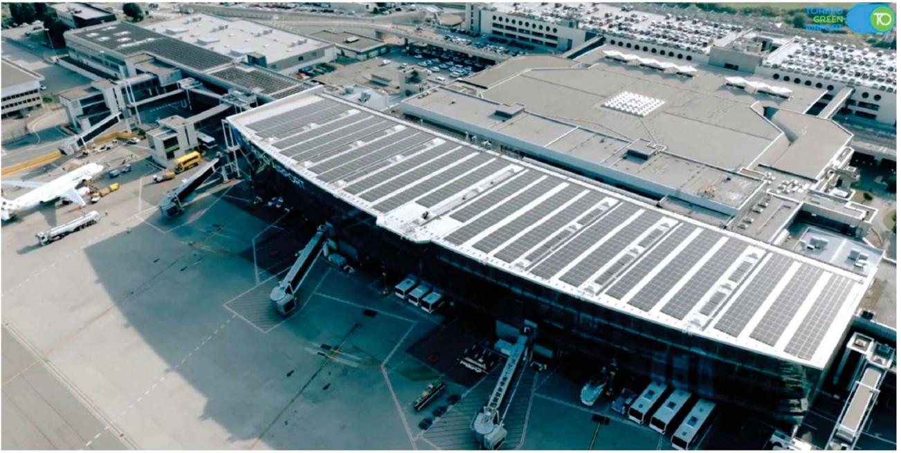
*Figura 34: Nuovo impianto fotovoltaico*
