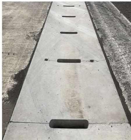
*Figura 15: nuovi fognoli per lo smaltimento delle acque meteoriche*
