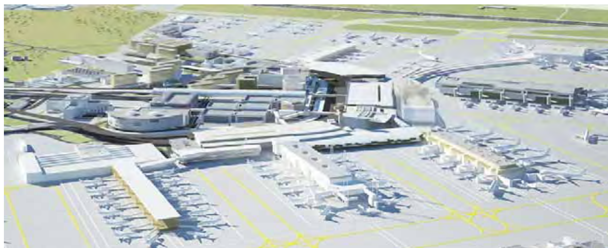
Figura 3 – Il nuovo complesso infrastrutture di Terminal lato est
