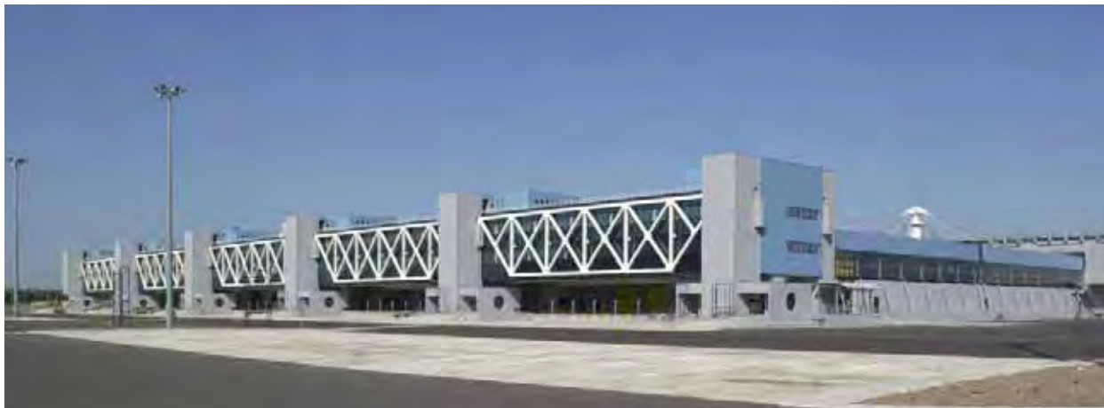
Figura 6– Cargo city – Edificio principale
