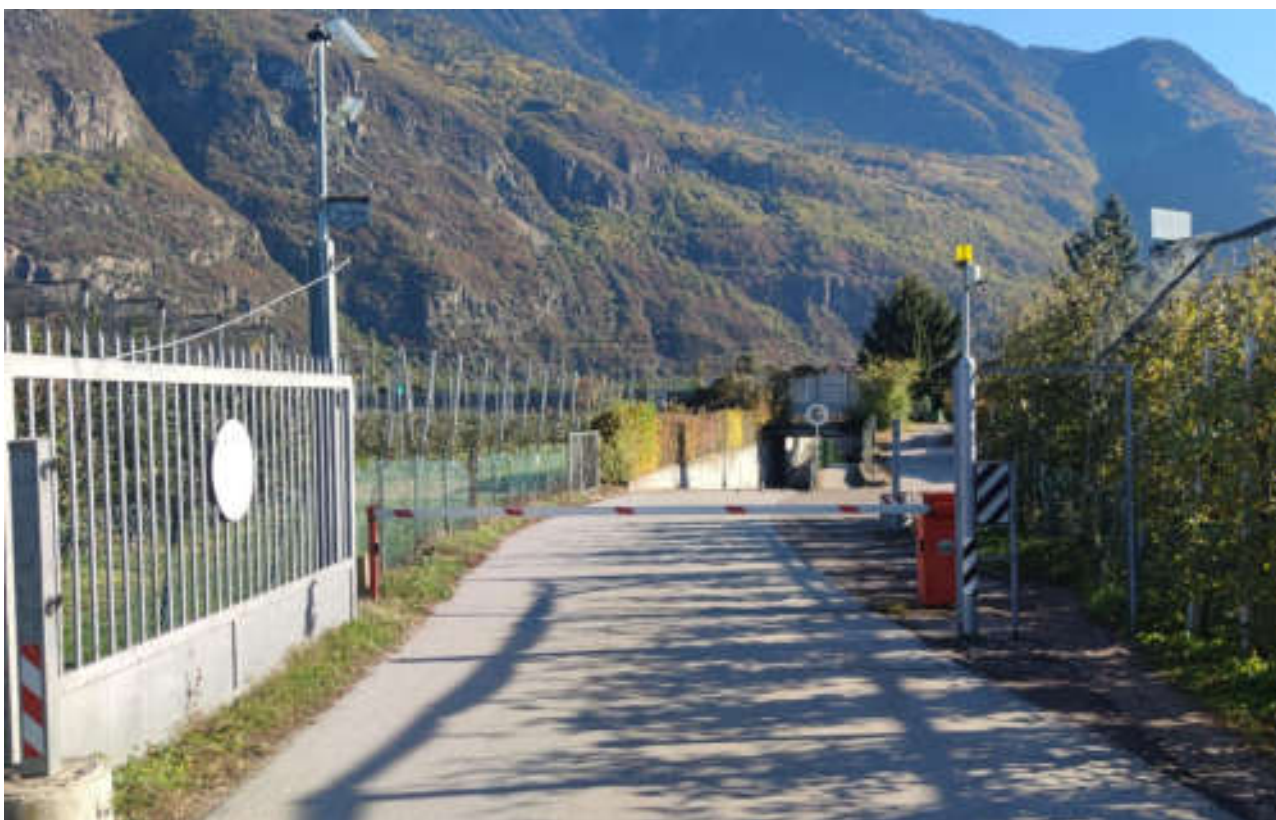
Figura 23: Foto L – Via Manzoni in corrispondenza del sottopasso carrabile della ferrovia.
