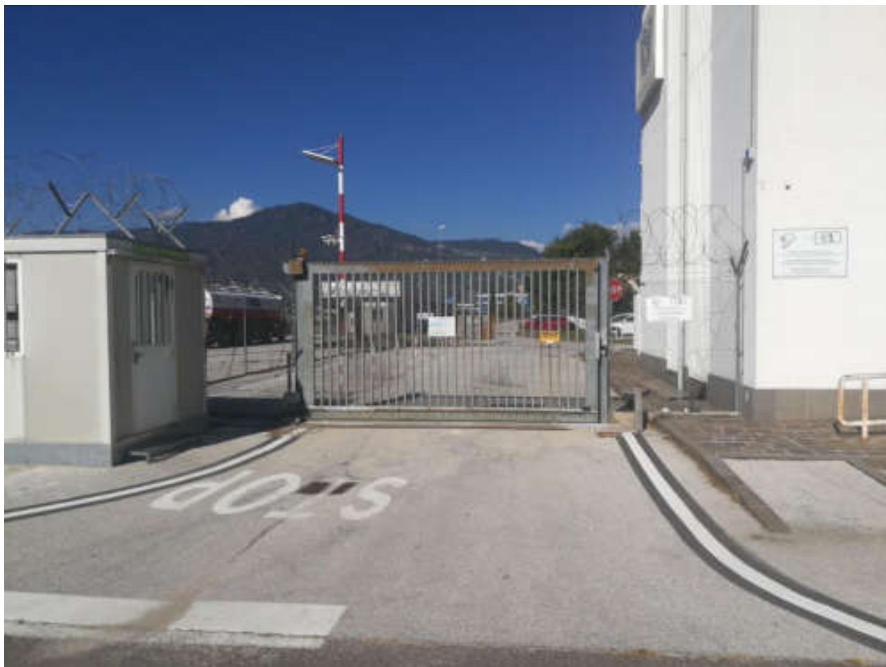
Figura 11: Foto B – varco carraio principale dell'aeroporto di Bolzano. In caso di emergenza viene immediatamente presidiato dalla Guardia di Finanza per gestire gli ingressi ed uscite. Il cancello non è abbattibile ma possiede un pulsante di emergenza esterno per l'apertura.
