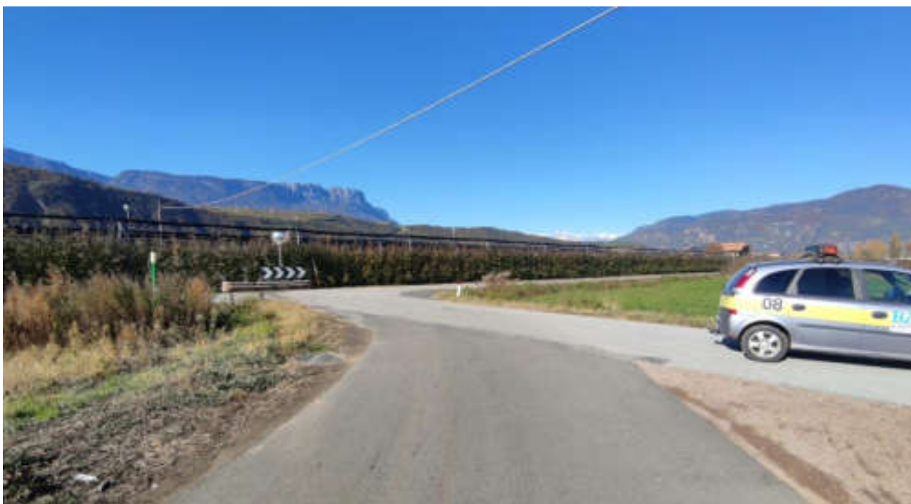
Figura 19: Foto H – incrocio via Campofranco (strada consorziale) con via Manzioni (strada consorziale). L'altezza della linea elettrica permette il passaggio di mezzi alti.
