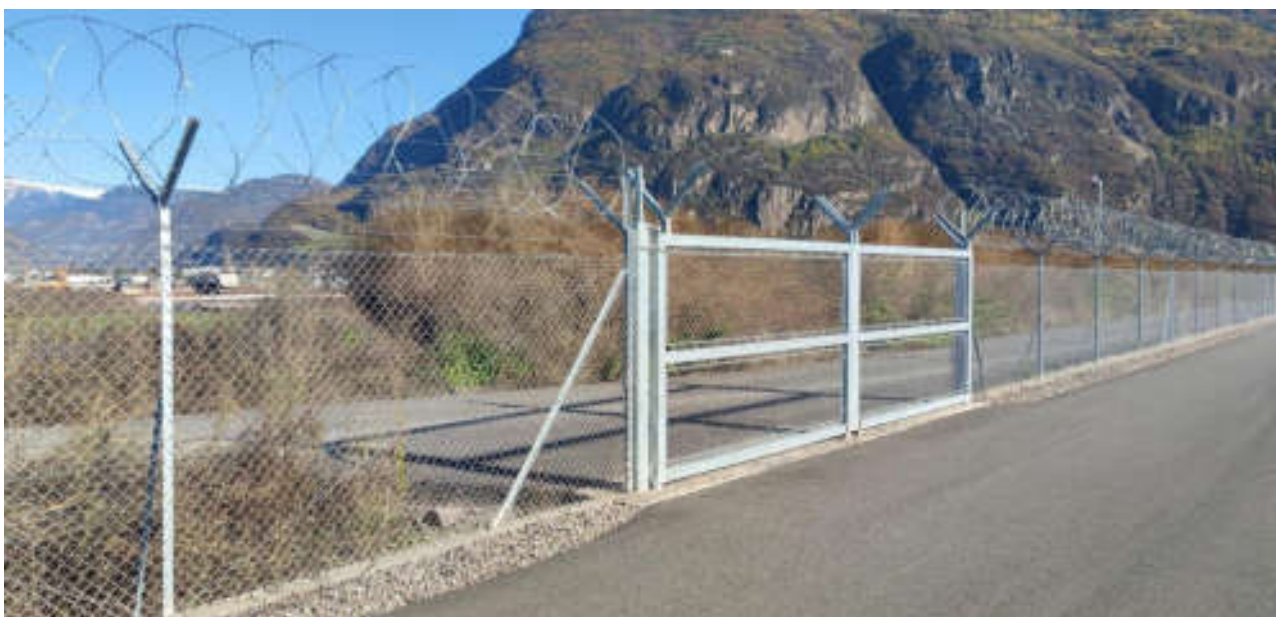
Figura 15: Foto D – vista sul cancello di emergenza primaria nella parte più a sud del sedime collegato con la strada perimetrale esterna all'aeroporto (via Manzoni).
