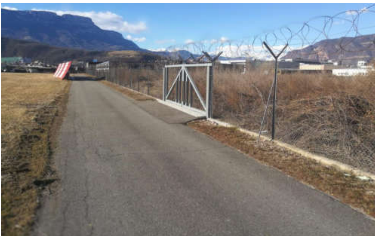
Figura 10: Foto A – cancello di emergenza a nord raggiungibile dalla via perimetrale.
