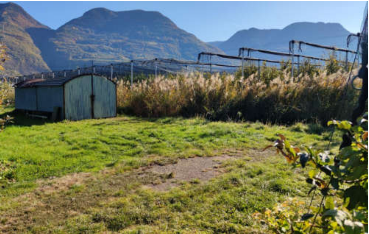
Figura 27: Foto T – Vista sul fossato (coperto da ampia vegetazione) al confine della strada del comune di Bolzano. L'area è utile per un eventuale inversione di marcia ma traccia un naturale confine delle aree di intervento VV.F..
